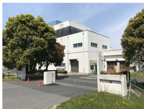
写真-2 対象地 既存施設
