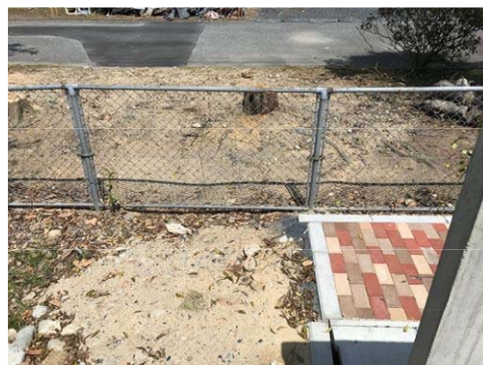
写真-18 対象地最北端（北東部）
