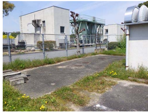
写真-10 地下構造物（重油タンク）
