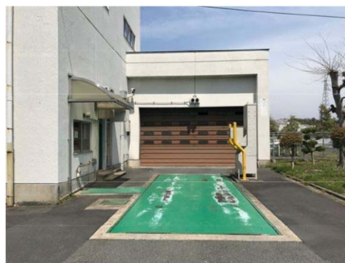
写真-6 地下構造物（トラックスケール）
