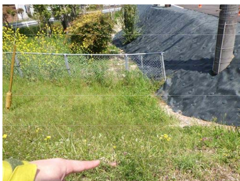
写真-3 対象地南東部（杭）
